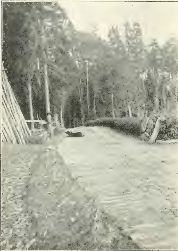
Abbildung 25. Ein 2½ Kilometer langer «Prügerweg» im lehmigen Boden bei Lannach in Steiermark.
